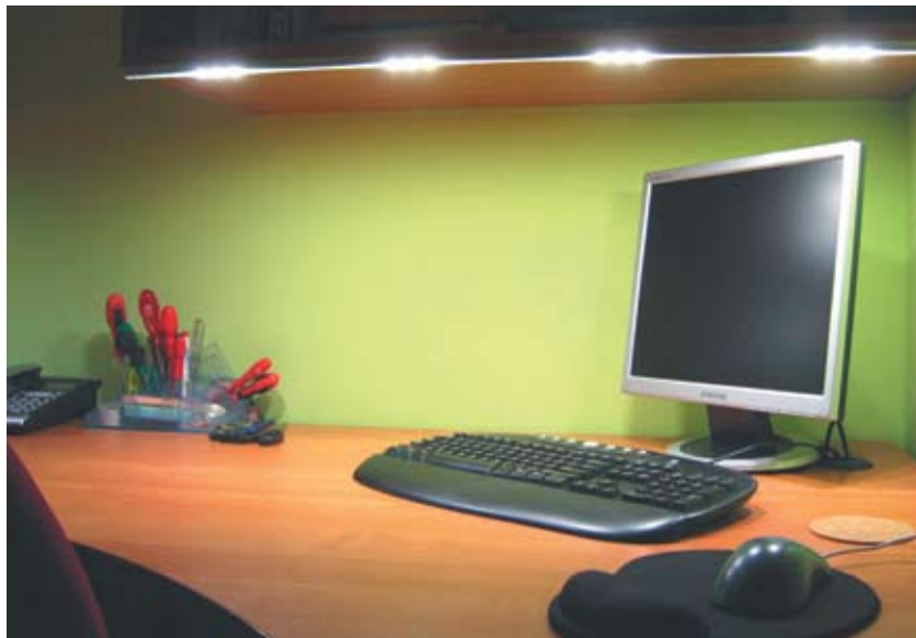
Рисунок 4 Освещение рабочего места на светодиодах марки XLamp
